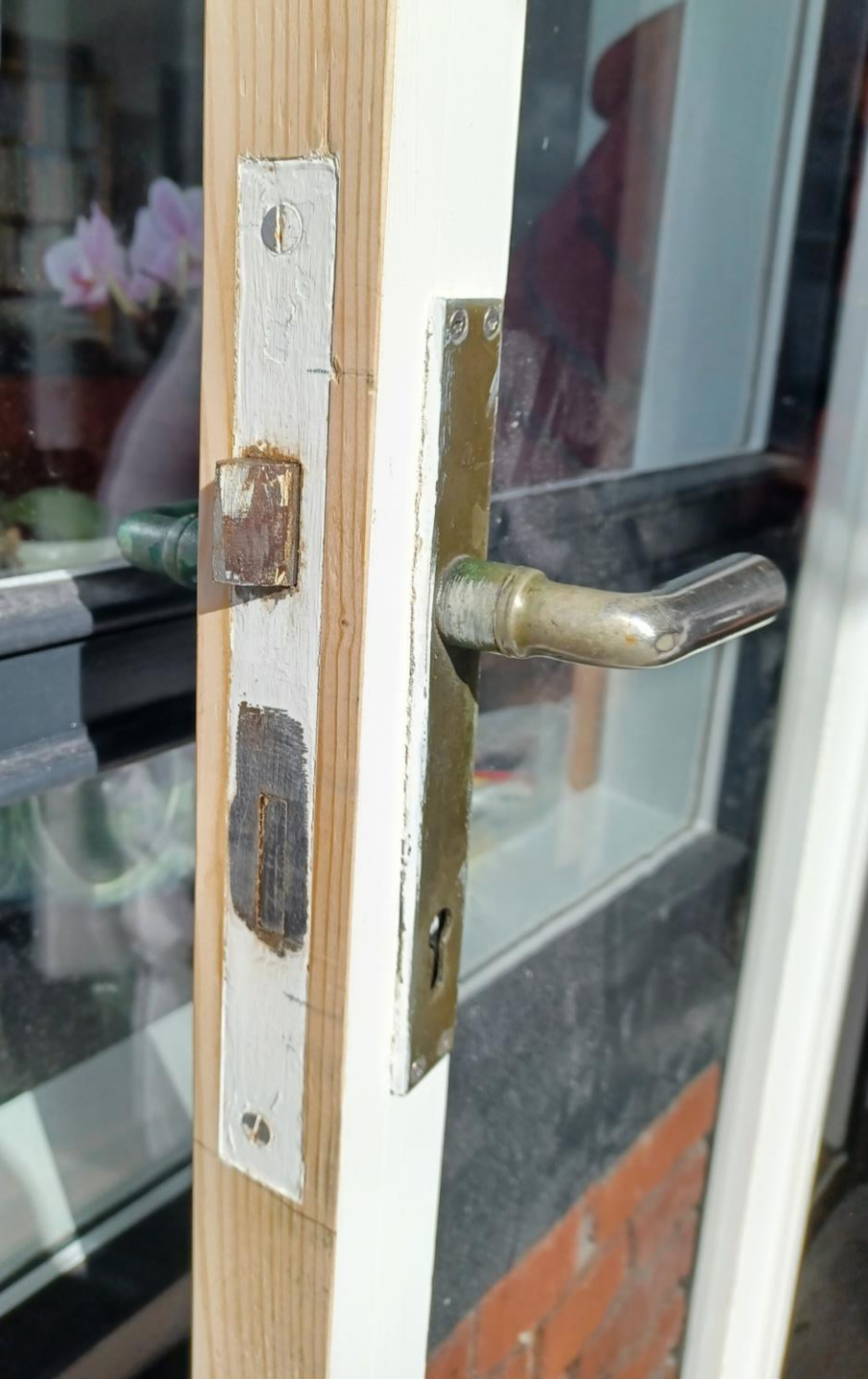
Udbedring af skadet dør, i proces.
