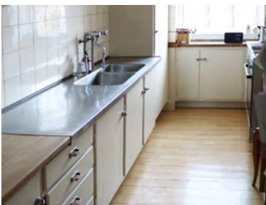
Forrammekøkken med stål- og fyrbordplader.
