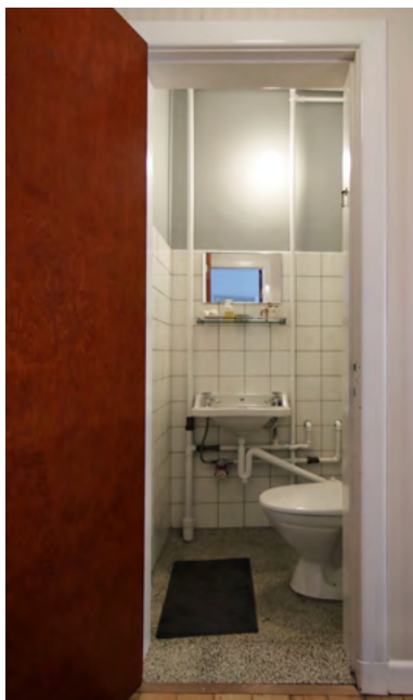
Toiletrum med funktionalistiske materialer og synlig rørføring.
