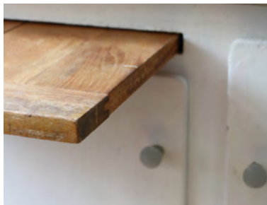
Udtræksplade som en del af element-tankegangen i forrammekøkkenets disponering.
