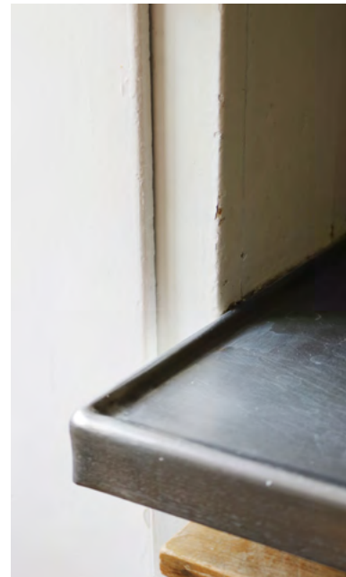
Fremadgående hjørne på bordplade i rustfrit stål.
