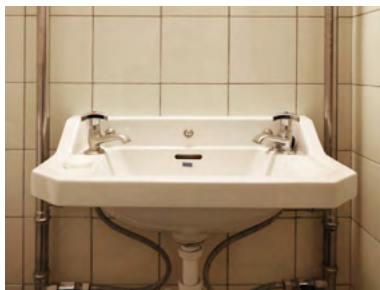
Oprindelig håndvask i toiletrum.
