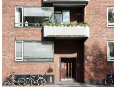
Reliefvirkning i facadens altan-karnap-motiv.
