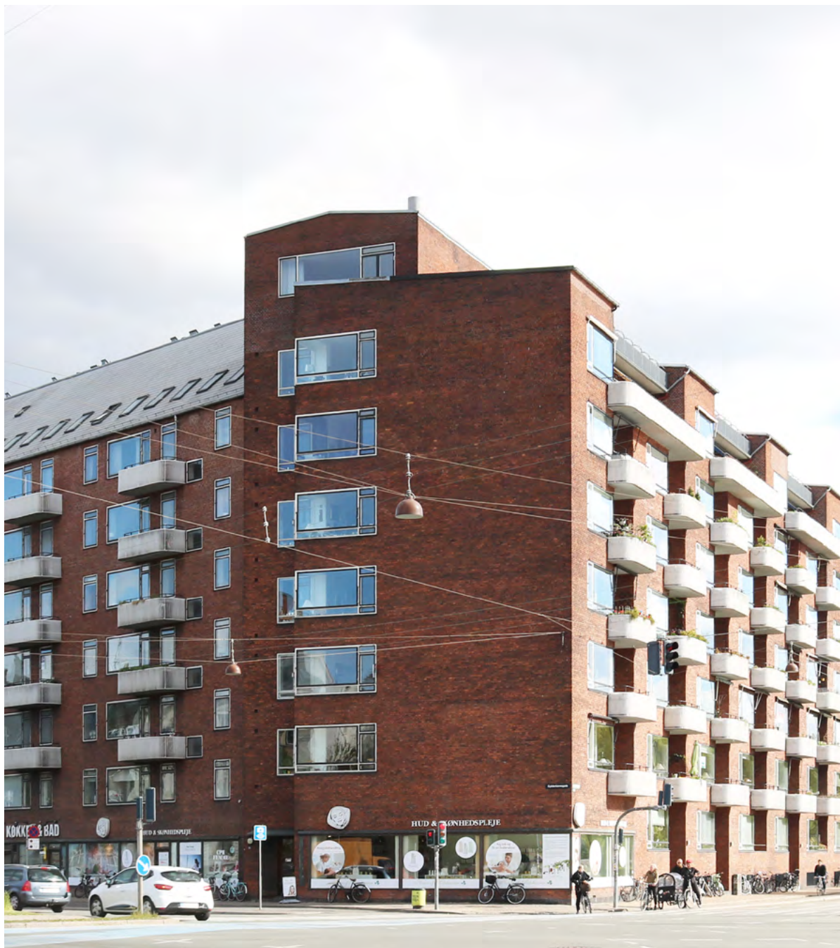
Vestersøhus i eftermiddagslys set fra hjørnet af Vester Søgade og Gyldenløvesgade. Vester Søgade-længen ses med reliefvirkning i det gentagede altan-karnap-motiv. Gyldenløvesgade-længen ses med en mere glat karakter uden tilbagetrukne partier.
