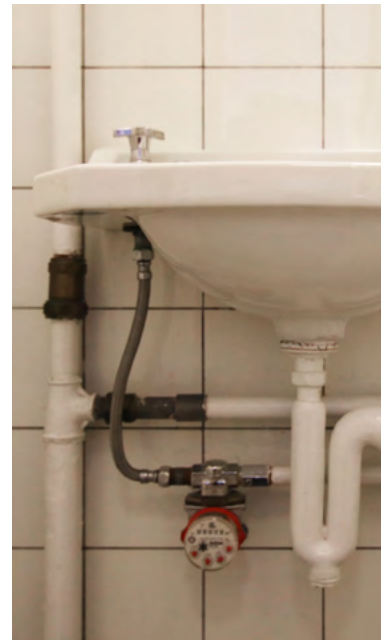
Oprindelig håndvask i toiletrum.
