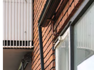
Murværk, altan, vinduesparti og markise.
